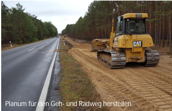
Einbau des Geh- und Radweges
